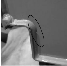
图 13 样件 3#直角焊缝处开裂
