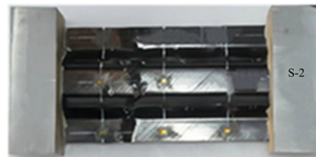
(a) 试件S-2长桁破坏模式
