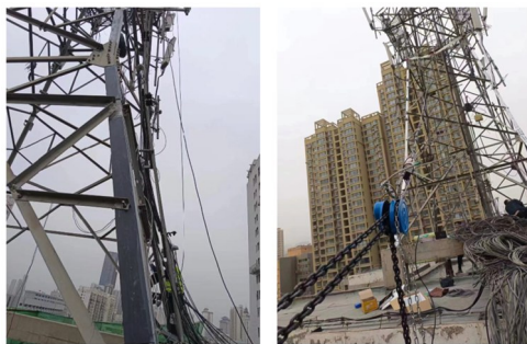
(a) 加固层实物图 (b) 拉力试验现场
